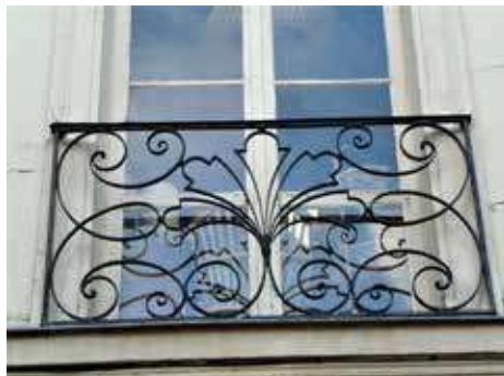
Garde-corps de la maison du notaire Lamy, rue au Pain ©PhCachau
