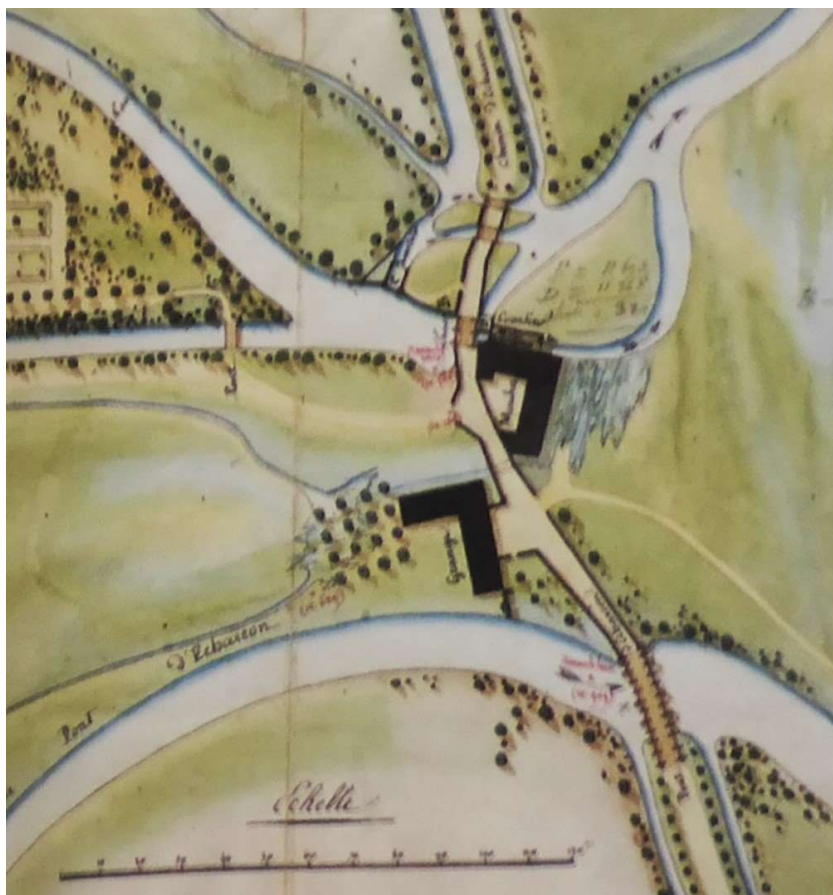
Fig. 3 : Détail du moulin primitif d'Écharçon, 1822. AD 91, 7 S 6.
