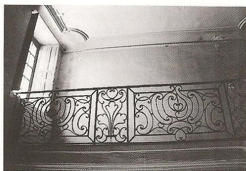
Fig. 70 – Détail de la grille du palier du premier étage.
