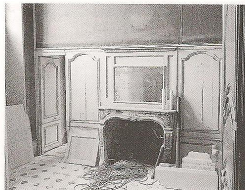
Fig. 93 – Pièce de bain du rez-de-chaussée.
