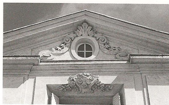
Fig. 22 - Haut de l'avant-corps central côté cour (détail).
