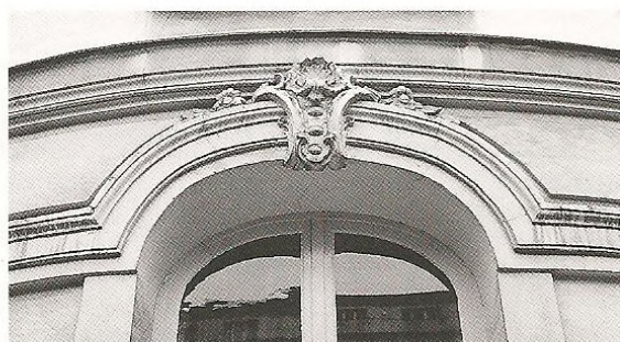
Fig. 15 - Mansart de Sagonne, Jules-Antoine Rousseau, Profils et agrafe centrale de l'avant-corps sur jardin de l'hôtel de Mannevillette, 1746 .
