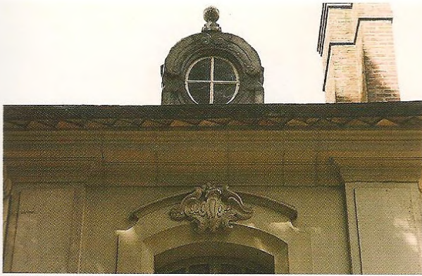
Fig. 40 - Détail du premier étage des pavillons latéraux, côté jardin.
