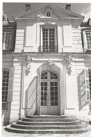
Fig. 21 - Avant-corps central sur la cour.
