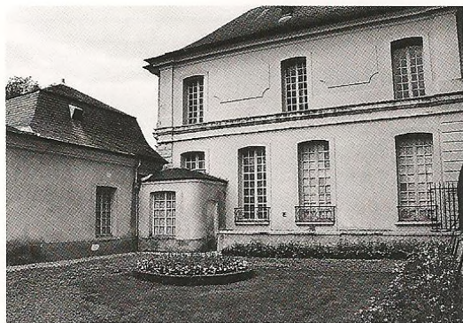
Fig. 44 - Vue latérale du château derrière le pavillon des cuisines.
