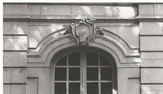
Fig. 39 - Profils et agrafe au rez-de-chaussée d'un des pavillons latéraux, côté jardin (détails).
