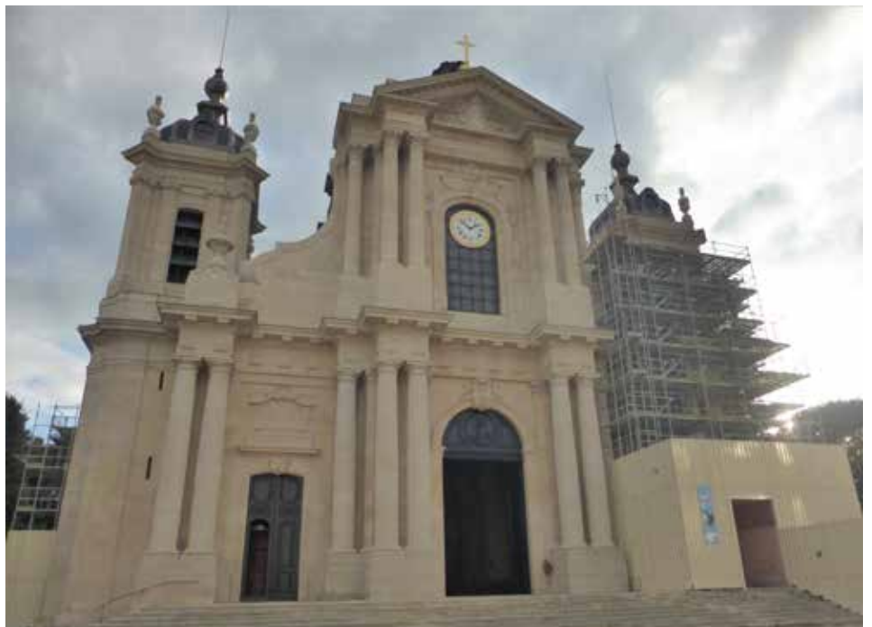
Eglise en restauration, septembre 2022 © P. Cacheu
