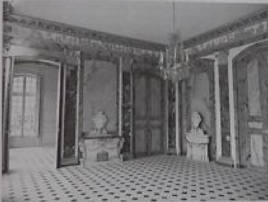
11. Charles De Wailly. La salle à manger du château d'Amières, état actuel.
