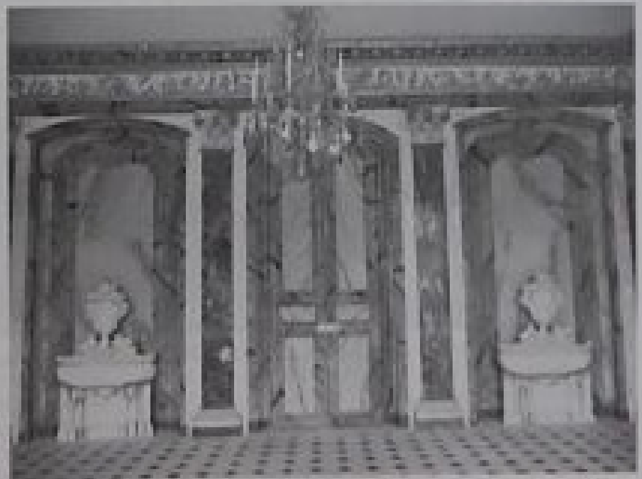
12. Entrée et fenêtres de la salle à manger du château d'Amières de côté du grand escalier. (Restauration en temps d'art, 2000).
