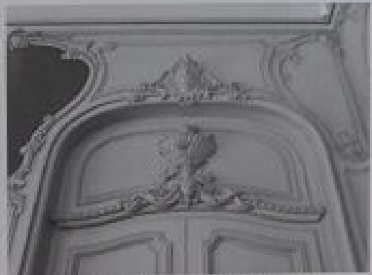
15. Détail de la galerie du château d'Asnières, état actuel, détail.
