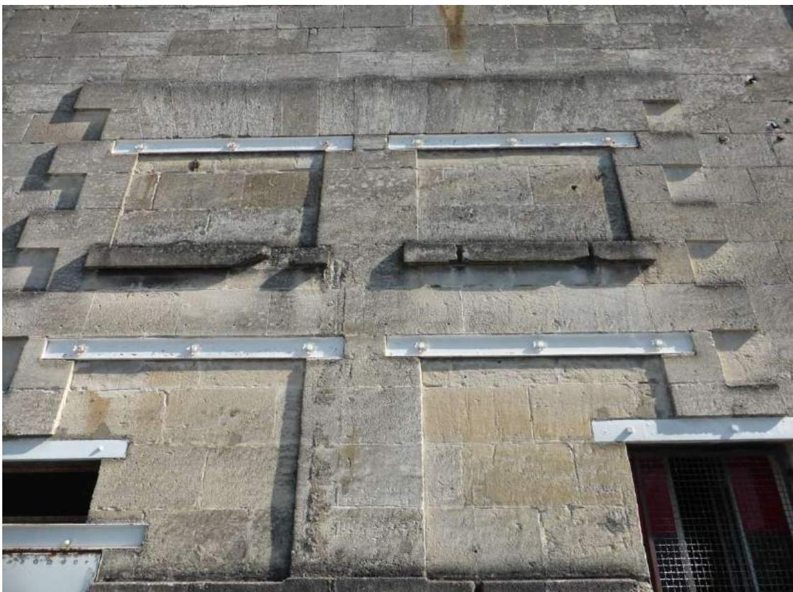
**Fig. 95 : Détail des baies à chainages harpés et linteaux de fonte, ornés de fleurs sur les boulons**
