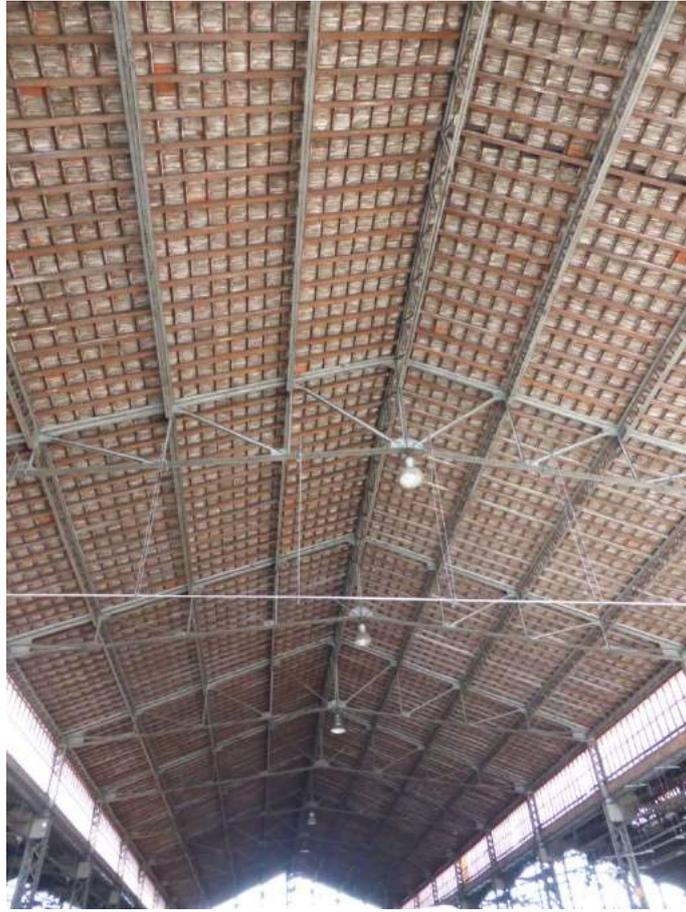
**Fig. 104-105 : Charpente métallique de la halle, travée centrale**
