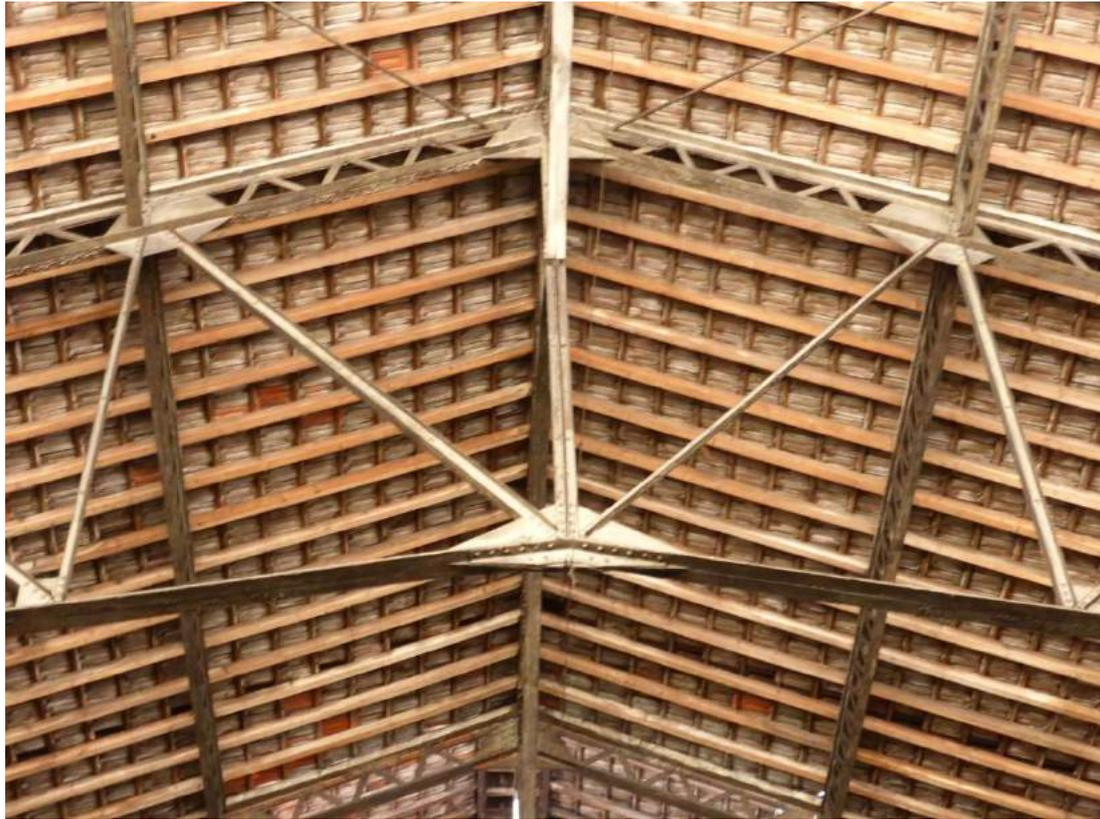
**Fig. 106-107 : Détails de la charpente métallique de la halle Lescure**
