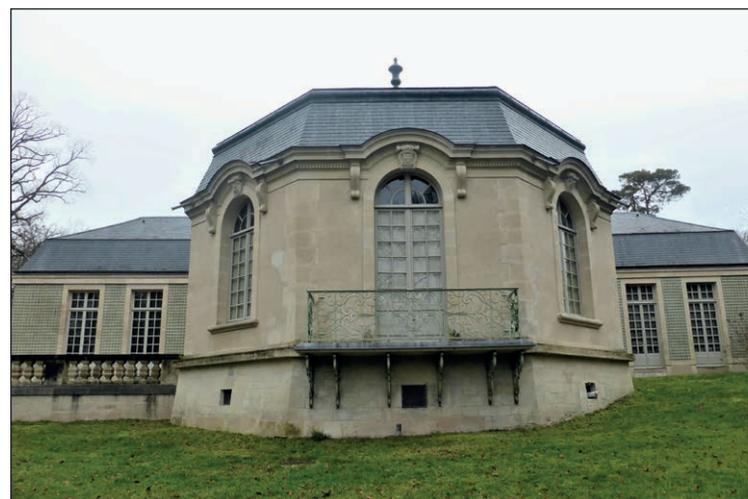
Le duc d'Aumale et son architecte optèrent finalement pour une solution intermédiaire, composée d'une corniche extérieure et d'un comble brisé octogonal de même hauteur que celui de la maison (fig. 11). Suivant la tradition des XVII<sup>e</sup>-XVIII<sup>e</sup> siècles, il fut pourvu d'un bourseau<sup>46</sup> de plomb sur la ligne de brisis<sup>47</sup> et d'un faitage composé d'un vase de plomb doré. Cette solution permit de réduire le montant à 64 134 francs<sup>48</sup>.
