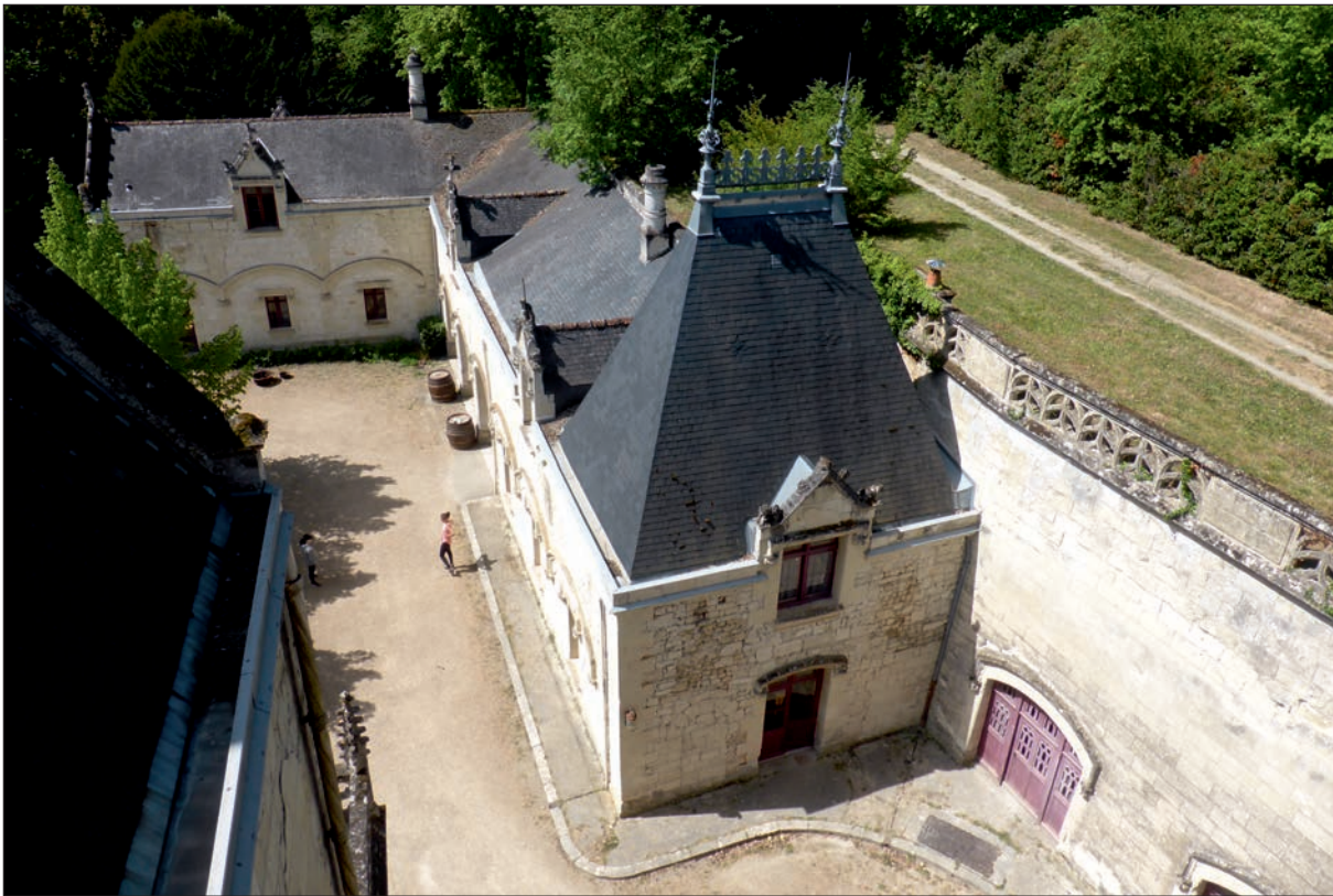
Fig. 9. Vue générale de la grande cour depuis la chambre haute de la grande vis.
