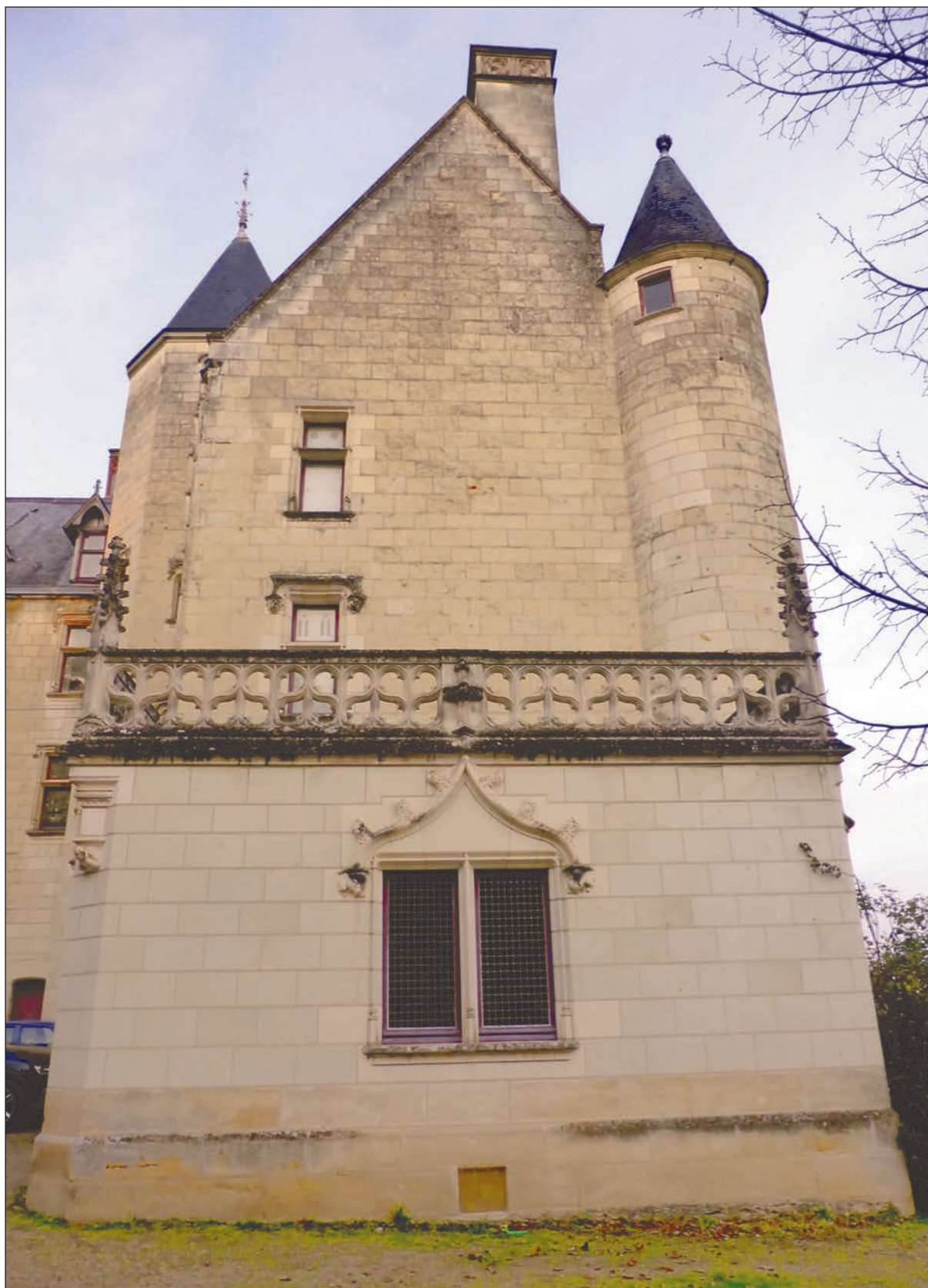
Fig. 21. État actuel du flanc gauche du château.
