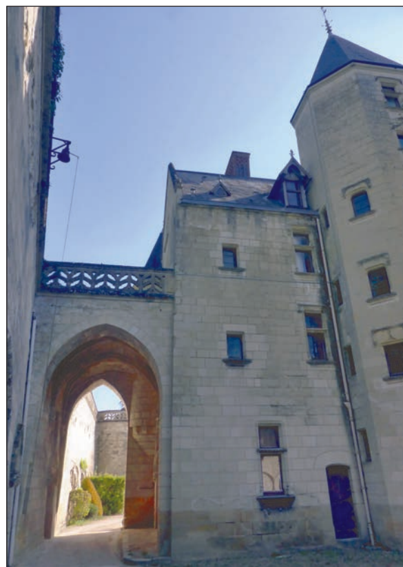
Fig. 12. Le château du côté de l'entrée du parc.
