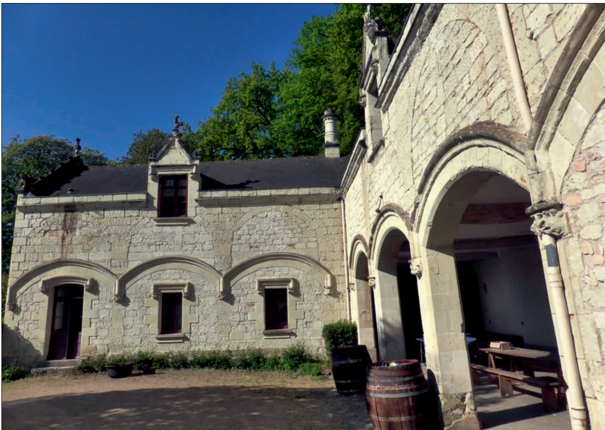
Fig. 10. Aile en retour de la grande cour du château. Marques des anciennes arcades XVIII e au-dessus des arcs, années 1870.
