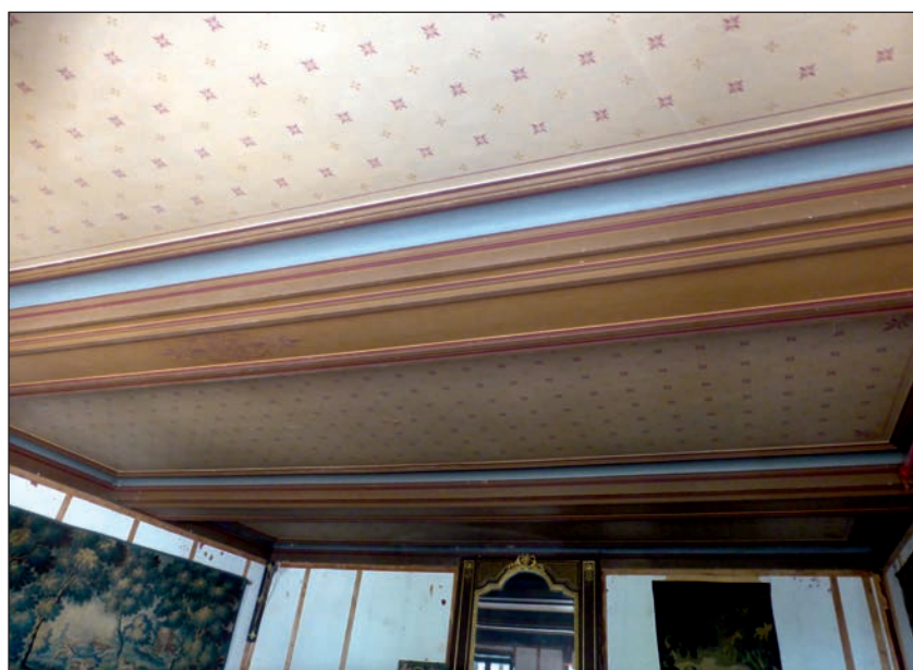
Fig. 26. Pierre-Marie-Arsène Lafargue, plafond à caissons et solives peintes du château de Sonnay, fin XIX e siècle.
