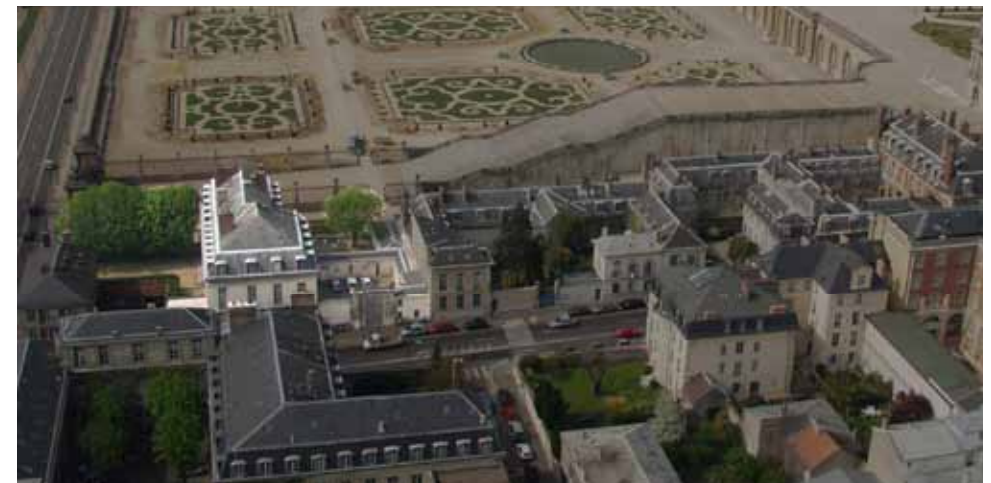
Fig. 2 – Versailles, vue aérienne des anciens hôtels de Beauvillier (en clair), de Chevreuse (à droite ; détruit) et Colbert de Croissy (en face), rue de l'Indépendance américaine (Cliché Château de Versailles, direction du Patrimoine et des Jardins).
