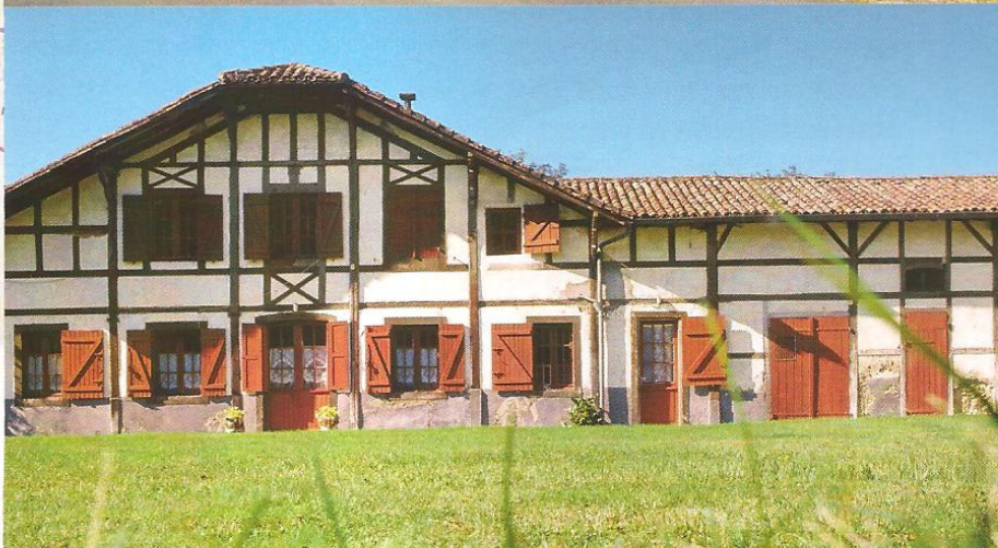
Les fermes impériales de Solférino furent les premières constructions du site. 14 furent programmées, 9 bâties et 8 sont conservées aujourd'hui, dont celles de Taston (en haut) et de Pouy (en bas).
